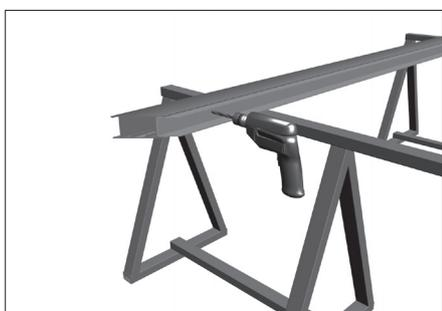
Просверлите отверстия сверлом  $\varnothing 4,2$  мм для крепления профилей для сборки панелей к основному несущему профилю. Расстояния между отверстиями должно составлять не более 150 мм.
