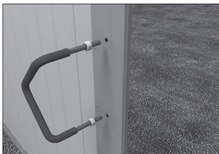
Просверлите 2 отверстия  $\varnothing 12$  в створке.
